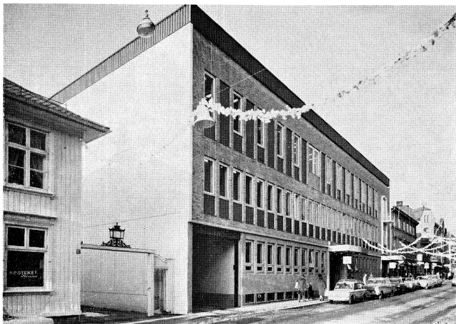
Sandefjord post- og telehus.
